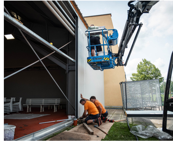
Arbeiten am Gebäude
