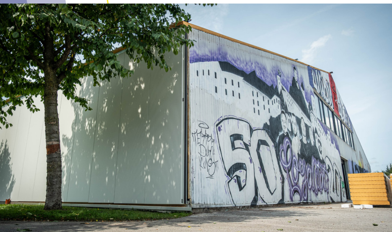
Halle im Umbau
