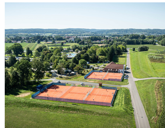
Gesamte Anlage und Clubhaus
