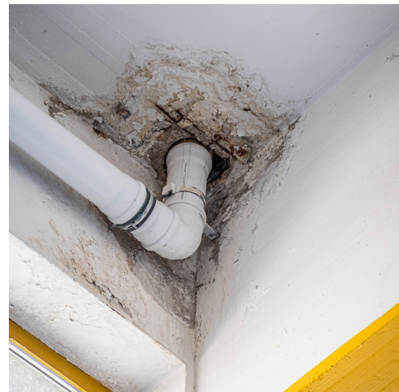
Undichtes Rohr
